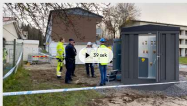
Polisen, Elsäkerhetsverket och Sundsvall elnätets personal utreder vad som orsakat olyckan. Foto: Per-Erik Stein/SVT
