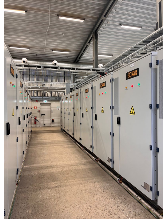
Bilder: 5,5 MW | 6,0 MWh BESS från Hitachi som vi har installerat på egen fastighet.
