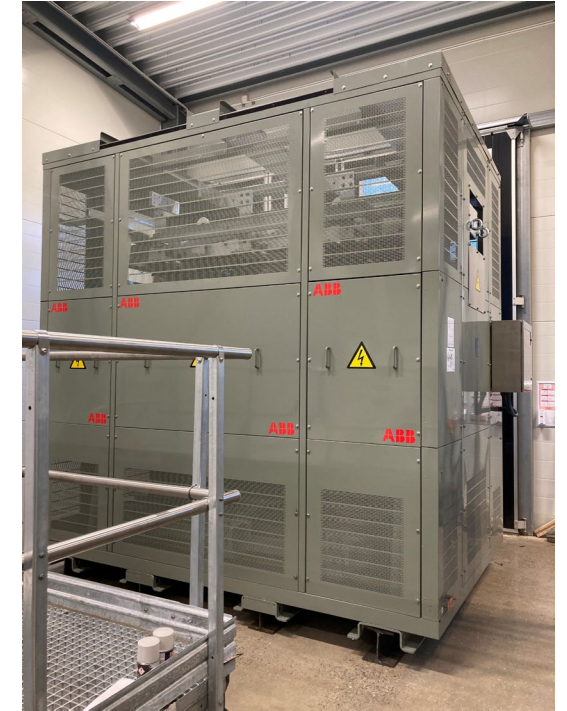
Bilder: 5,5 MW | 6,0 MWh BESS från Hitachi som vi har installerat på egen fastighet.
